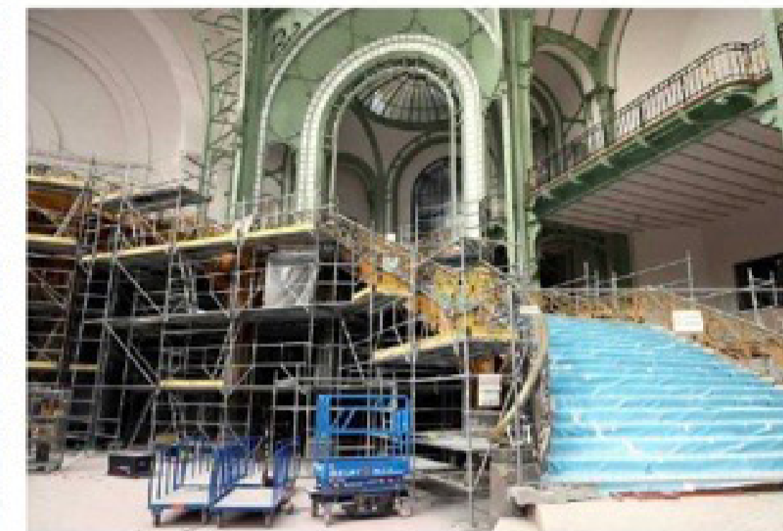
Paris (VIII e ), le 28 février. Des centaines d'artisans participent aux travaux de la nef du Grand Palais, qui doit accueillir les épreuves d'escrime et de taekwondo des JO.
