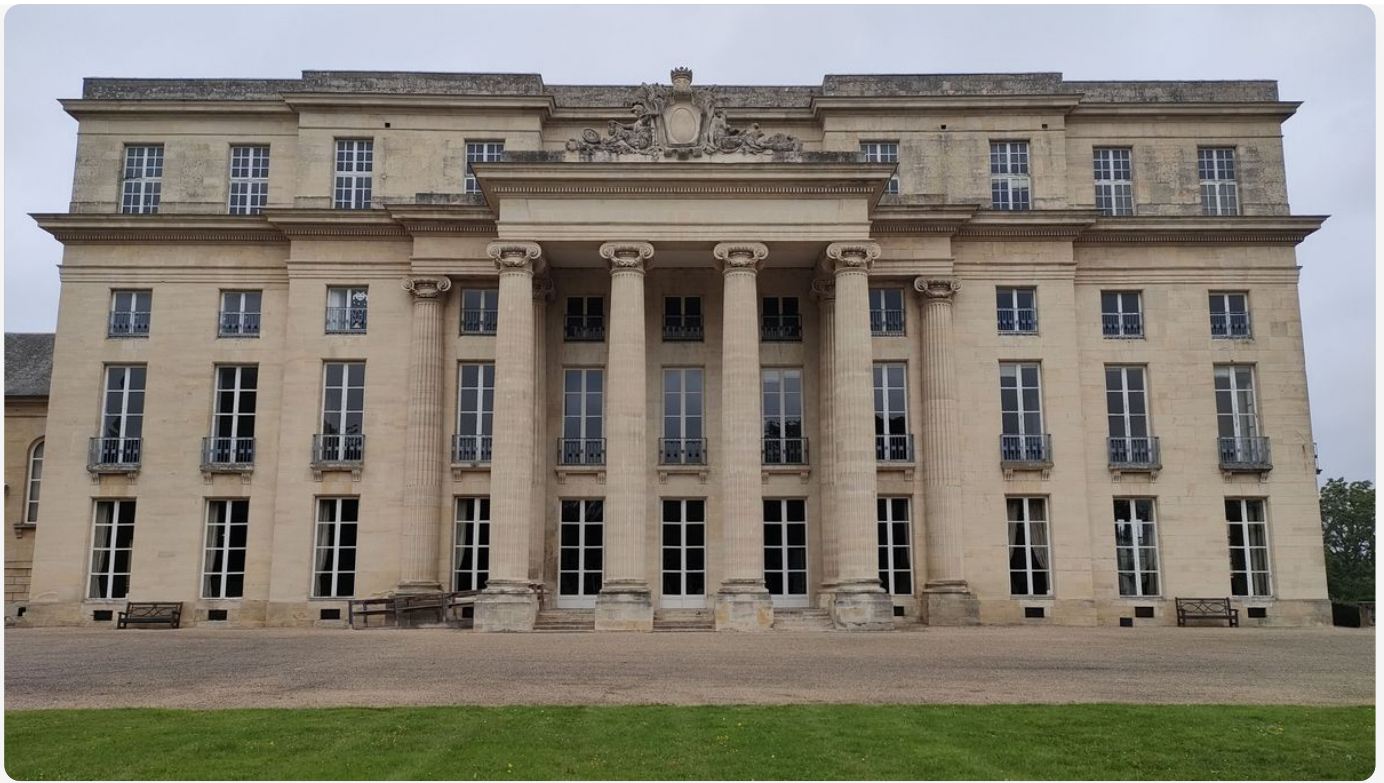
Le Château de Bénouville dans le Calvados a été construit en 1927 par l'architecte Claude Nicolas Ledoux © Radio France - Elodie Touchais
